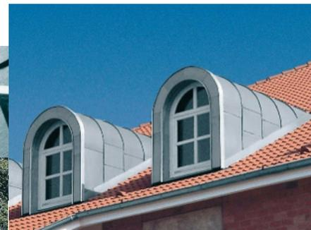
Wenn sofort Wärme gewonnen werden soll, bieten Thermokollektoren, die zum Beispiel unter Titanzink verlegt werden können, einen besonderen Reiz. Das Metall absorbiert die Sonnen- und Umgebungswärme und leitet diese über ein Rohrsystem direkt an Heizung und Haustechnik zur Wassererwärmung weiter.
